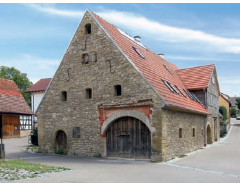
11 Kirchberg an der Murr, ehem. Stiftskelter während der Sanierung. Der 1926 abgebrochene Torbogen wird wieder hergestellt und mit Sandsteinquadern verkleidet.
