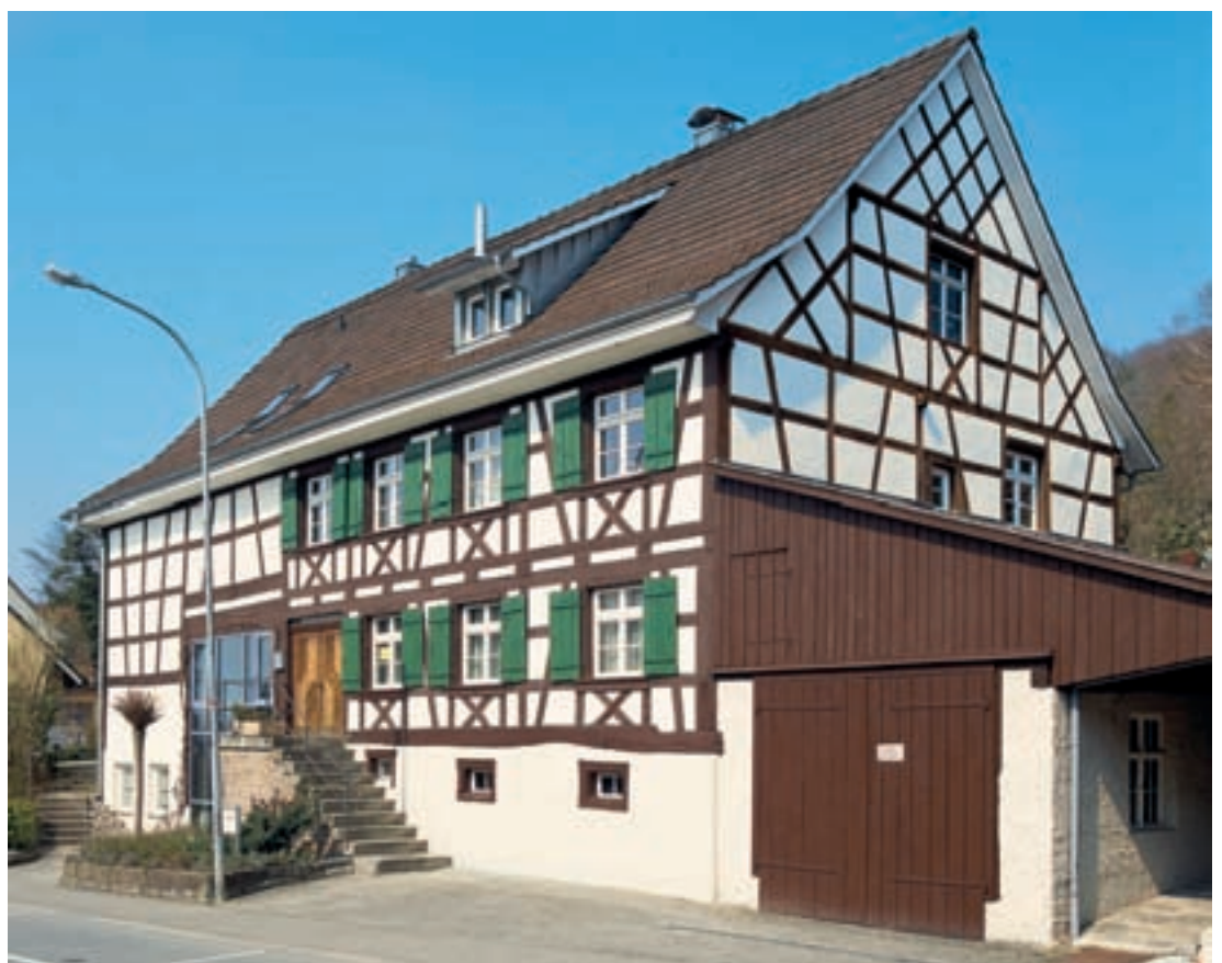
1 Das umgenutzte Bauernhaus vom Wohnteil her gesehen. Der Schopf im Vordergrund dient heute als Garage.
