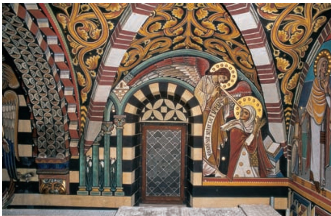
1 Südwand, Malerei der Wand- und Gewölbeflächen nach der Reinigung.
