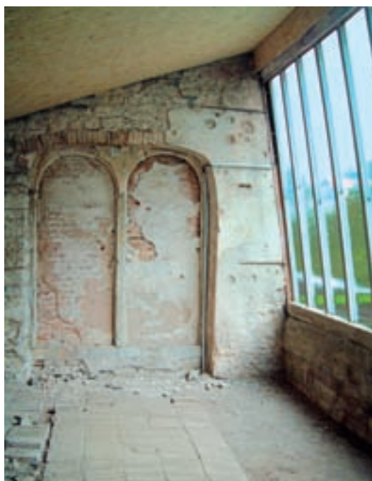
9 Messelhausen, Orangerie des ehemals Zobelschen Schlosses, Innenraum gegen die östliche Schmalseite mit den nachträglich vermauerten Rundbogenöffnungen.
