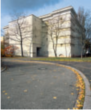
Mannheim-Käfertal, Kastellbunker am Bäckerweg. (LAD, Foto: B. Hausner, 2010)
