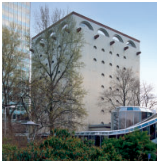
1 Im Alarmfall Schutz für 7500 Menschen: Ochsenpferchbunker in der Neckarstadt.
