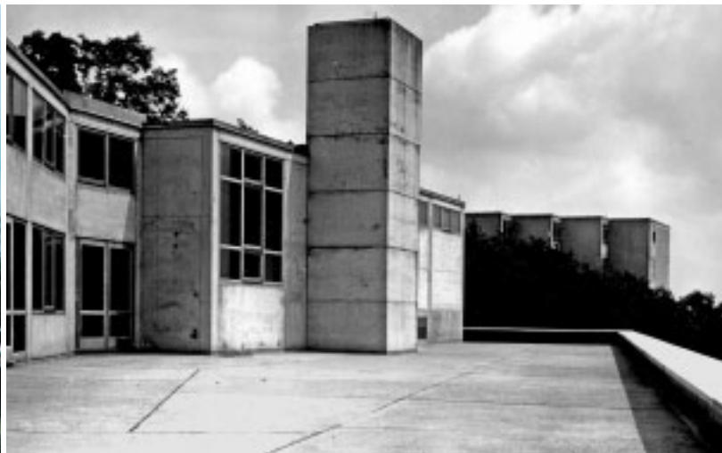
8 Terrasse im heutigen Zustand mit den bemoosten Pflastersteinen (links) und den originalen Waschbetonplatten (rechts) vor der Sanierung in den 1970er Jahren.
