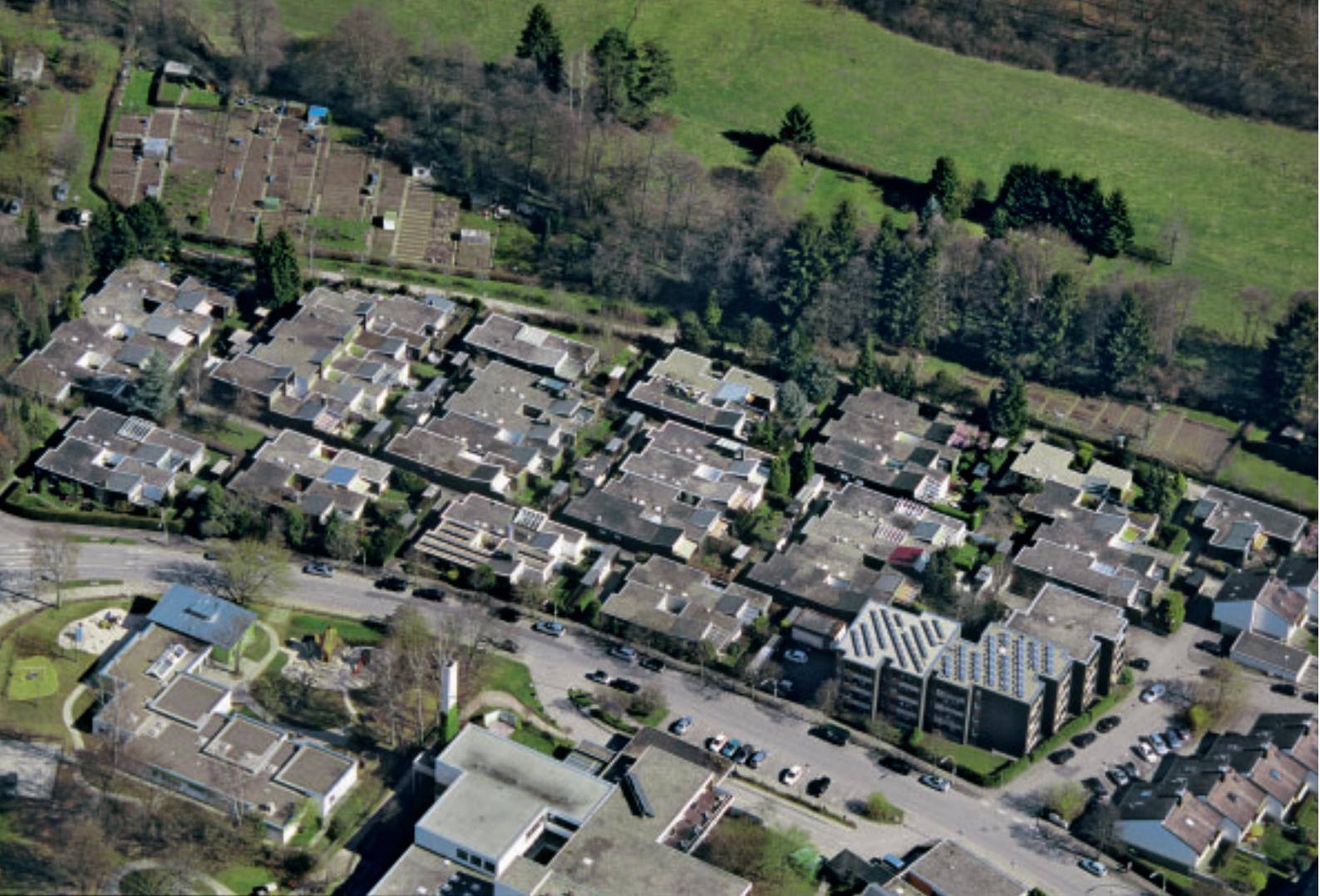
1 Luftbild der Wohn- bebauung Sommerhofen- Seestraße in Sindelfingen.
