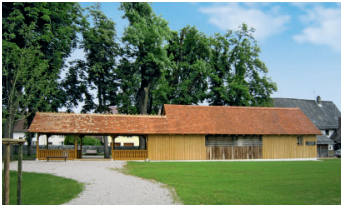
1 Der Kernbau von 1901, eine Trinkhalle mit integrierter Kegelbahn, wurde um 1905 mit einem schmaleren und niedrigeren Anbau um 10 m auf eine Gesamtlänge von etwa 25 m erweitert. Hinter der Kegelbahn die hohen Kastanien des Biergartens.
