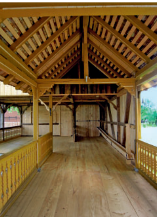
2 An Ruhetagen sichert eine verschlossene Tür das hintere Ende der Kegelbahn mit ihrem Kugelfang, rechts der Kugelrücklauf, links die Trinkhalle mit Durchreiche zum Ausschank. Gut ablesbar der zweite Bauabschnitt: der jüngere Anbau mit seinen nach Befund farbig gefassten Hölzern.
