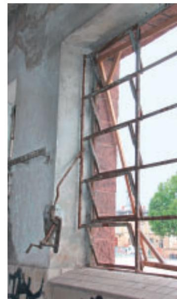
10 Karlsruhe, Durlacher Allee 60–66, Alter Schlachthof, Schweinemarkthalle. Vollständiger Metallfensterbestand für gute Durchlüftung: im Erdgeschoss gekoppelte Schwingflügel, in den Oberlichtaufbauten gekoppelte Wendeflügel.
