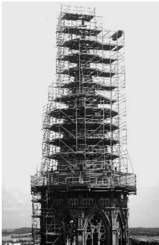
1 Blick auf den mittelalterlichen Unterbau aus Ziegelstein, darüber die Oktogonhalle mit Turmhelm aus Naturstein. Ansicht von Süden aus, 1999.
