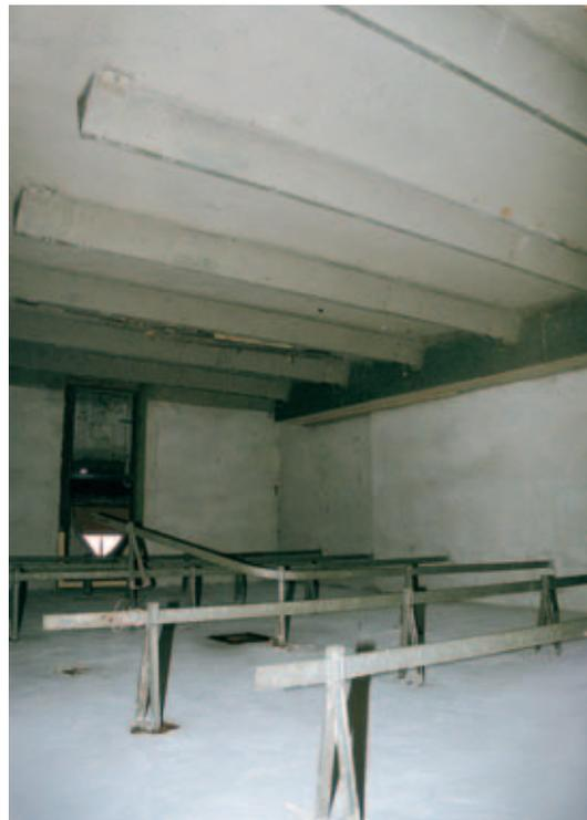
13 Erdgeschossflur mit begonnener Deckenabhängung.
