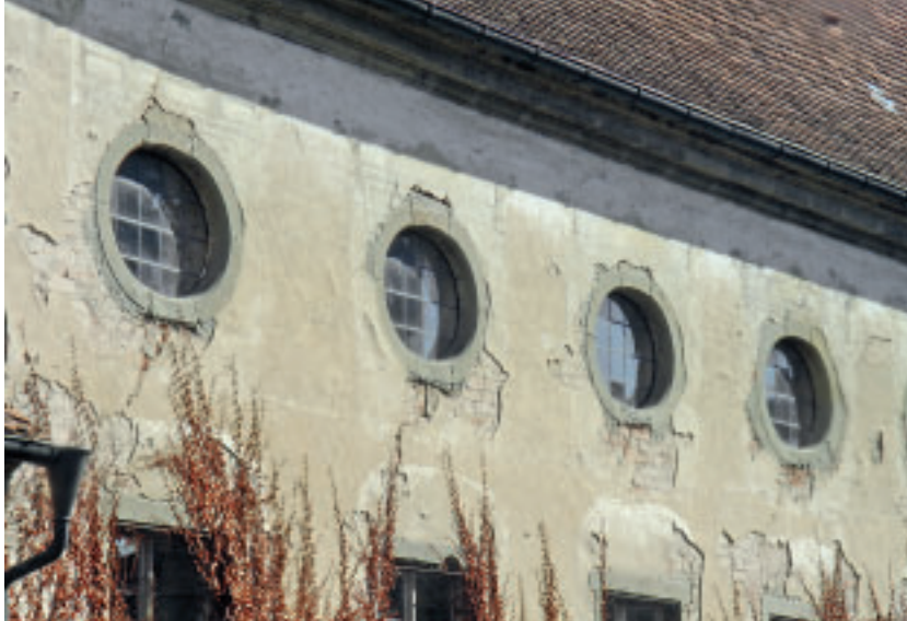
10 Zustand der Westfassade vom Kaisersaal mit Bewuchs 2009.
