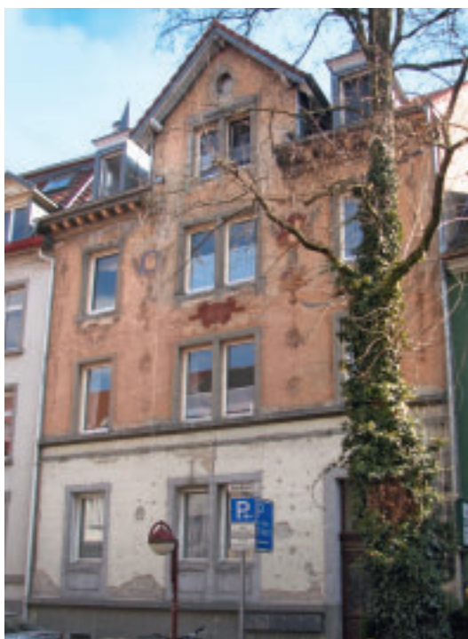
1 Das Haus Huetlinstraße 21 mit Eternitverkleidung, Aufnahme von 1986.
