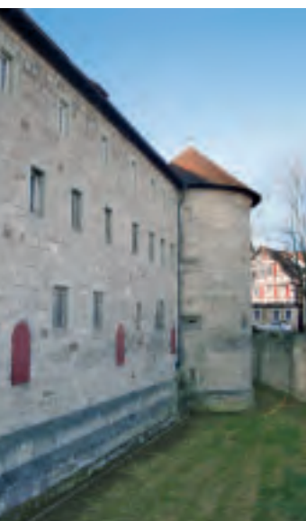
8 Stadtseitige Fassade und nordwestlicher Eckturm des so genannten Burgschlosses von 1538/41.
