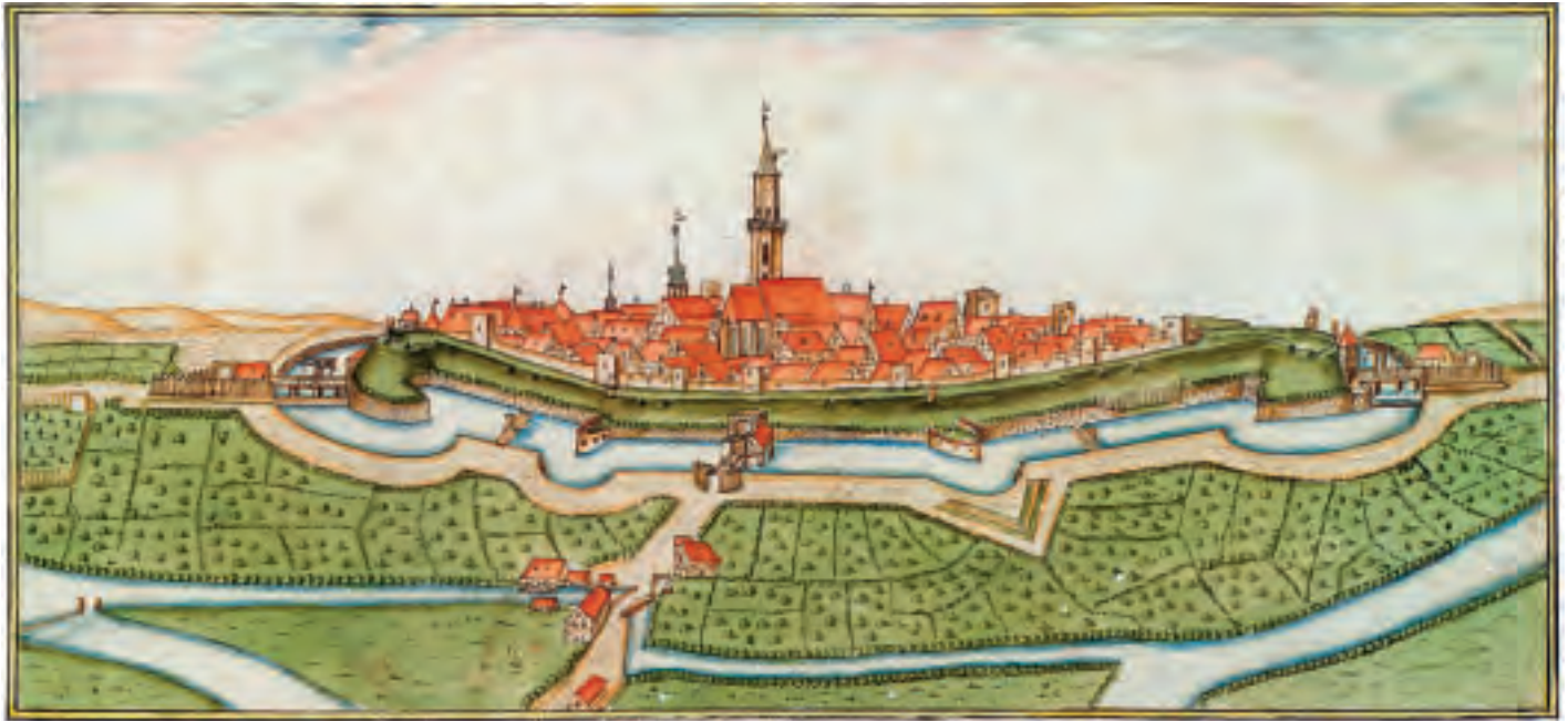
7 Nördliche Festungsflanke im Jahr 1686 mit Glacis, Ravelin, äußerem Graben mit Schleusen und Eskarpe-/Konteres-karpemauern, Kaponnie-ren, Torbastionen mit Brücken und Palisaden, hinter dem Wall die spätmittelalterliche Stadtmauer mit zurückgebauten Mauertürmen. Stadtansicht aus den Forstbüchern des Andreas Kieser, Schorndorfer Forst.
