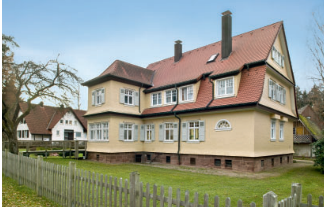
6 Albert-Schweitzer-Haus von Nordosten (Schramberger Straße 5).
