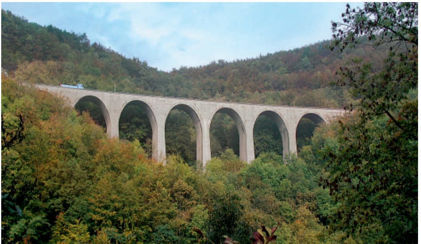
1 Drachenlochbrücke am Albabstieg.
