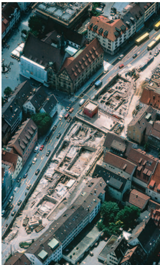
1 Ulm, Blick auf die Ausgrabungen in der Neuen Straße, von Osten nach Westen. Grabungsfläche mit zentral gelegener Info-Box. 2002.
