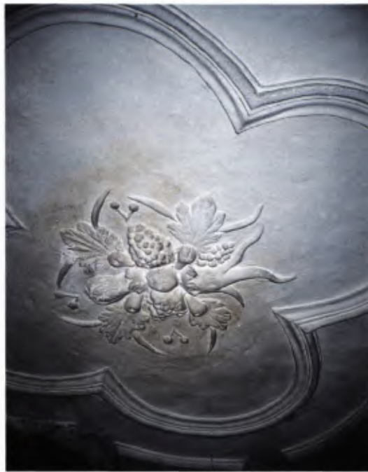
10 Barocke Stuckdecke, Beginn der restauratorischen Untersuchungen, 1994.
