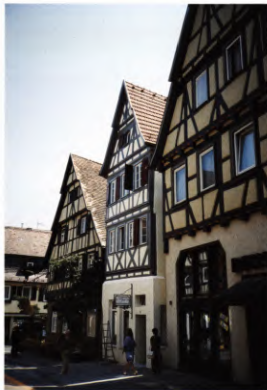
1 Herrenberg, Tübinger Straße 20. Nach einer Vordissensverhandlung mit dem Regierungspräsidium Stuttgart 1989 wurde das Fachwerk des kurz nach 1600 erbauten Hauses entsprechend denkmalpflegerischem Konzept im befundeten ursprünglichen Grau- und nicht wieder im Braunton gestrichen.
