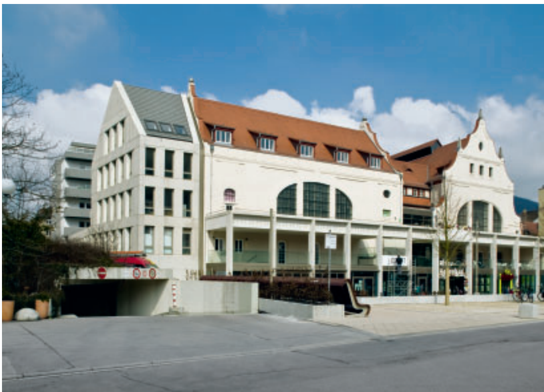
1 Südseite des Bergheimer Hallenbades nach der Sanierung, 2013.
