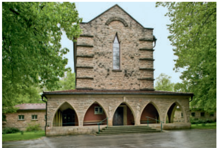
1 Schwenningen, Krematorium, Hauptfassade.
