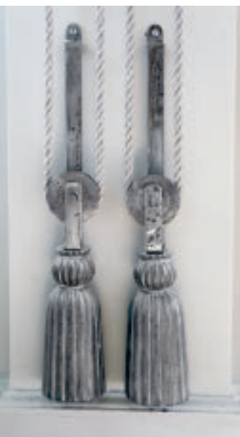
11 Historische Rollladenmechanik im Gartenzimmer.
