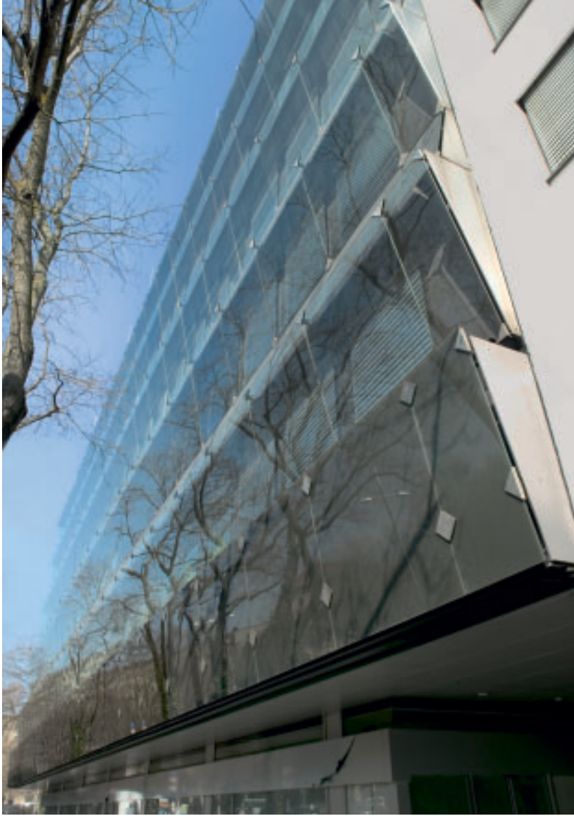
6 Zürich-Vita-Versicherungsgebäude in Stuttgart mit schallabsorbierender Fassade aus vorgespanntem, rahmenlosem Glas (Wilfried Beck-Erlang, 1963–1965).
