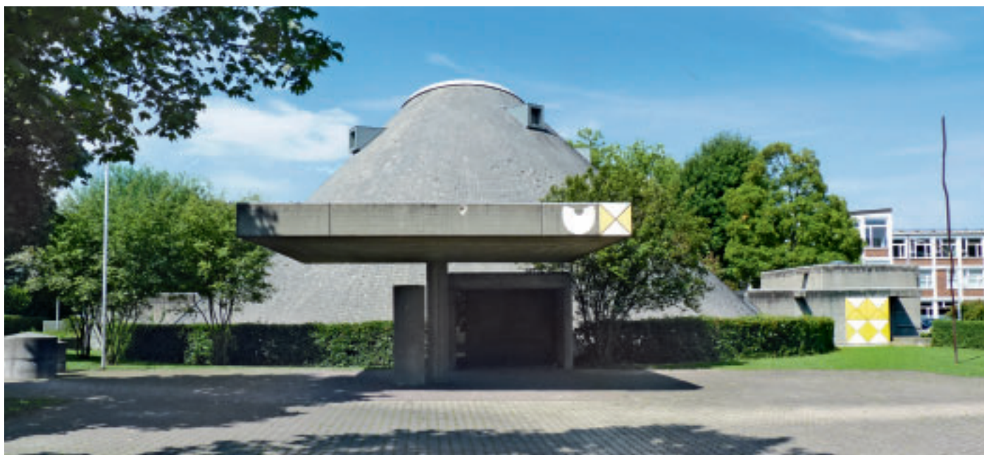
7 Schiefer, faserzementverkleideter Kegelstumpf der katholischen Kirche Maria Regina in Fellbach (Klaus Franz, 1963–1967)
