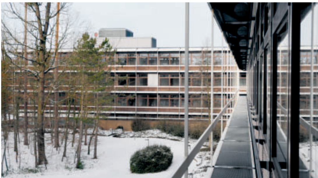
5 IBM-Hauptverwaltung in Stuttgart-Vaihingen: Flachdachkuben in Stahlskelettbauweise mit vorgehängten Balkonen (Egon Eiermann, 1967–1972).
