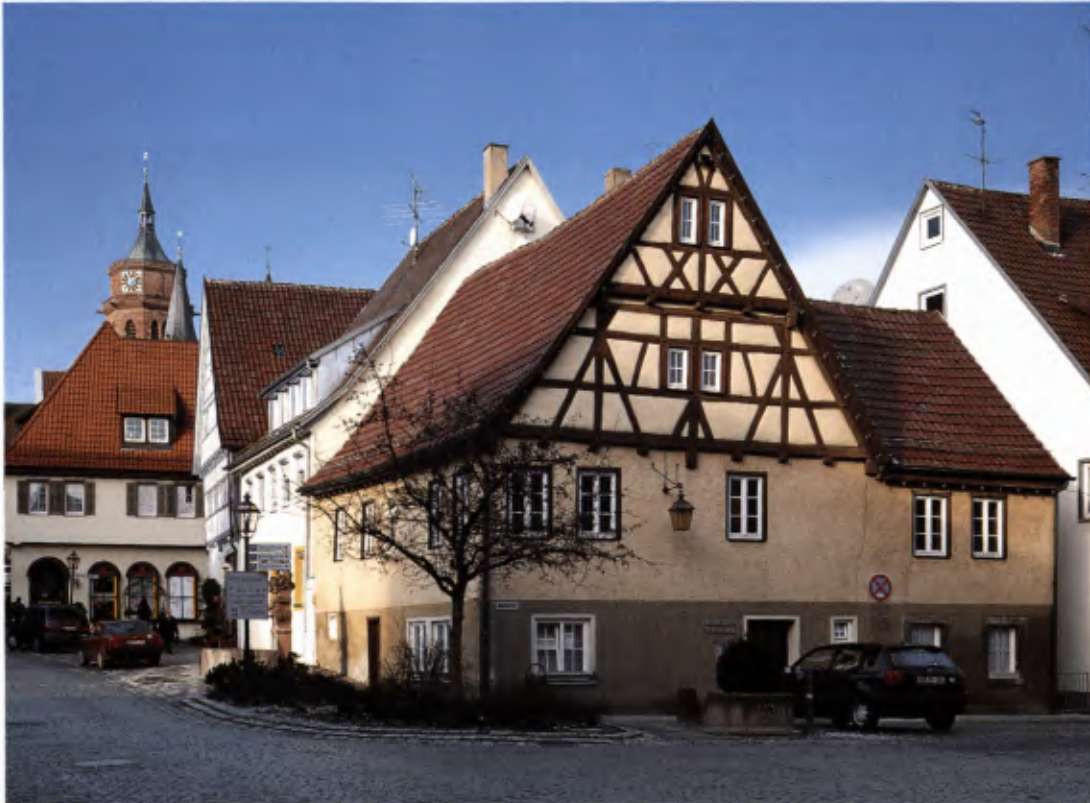
2 Ansicht des Gebäudes Stuttgarter Straße 31 von Südosten.
