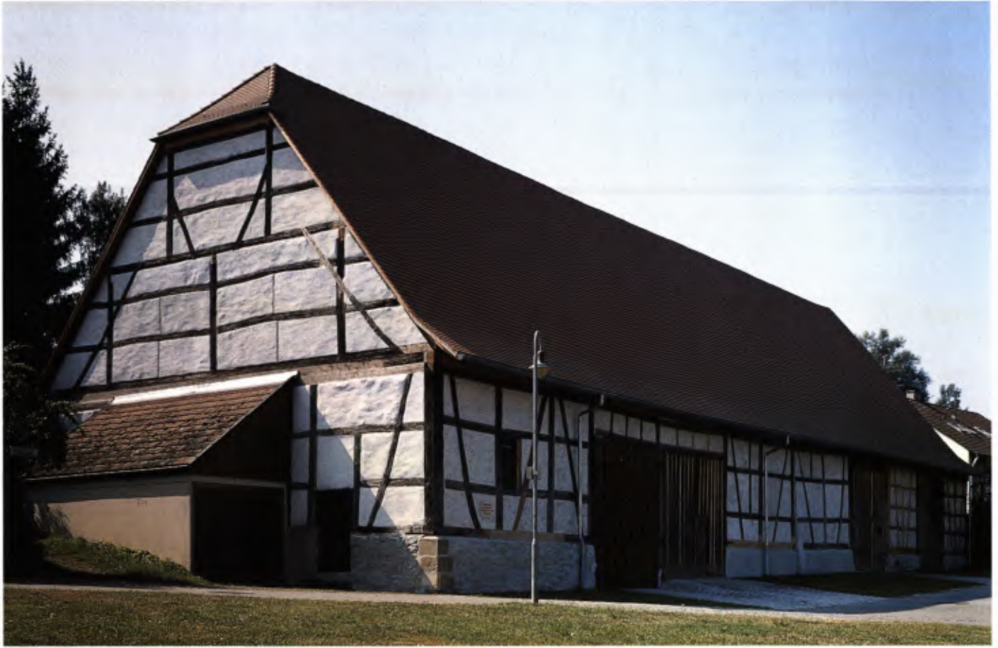
2 Die Zehntscheuer im Wirtschaftshof wurde zwischen 1998 und 2001 saniert.
