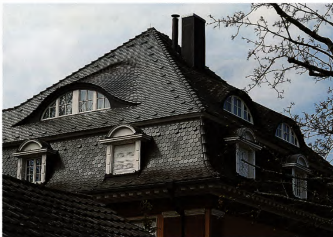
1 Konstanz, Franz-Liszt-Straße. Die Fledermausgaupen bieten nicht nur eine gute Belichtung des in Nutzung genommenen Walms, sondern geben den Blick frei auf den See.
