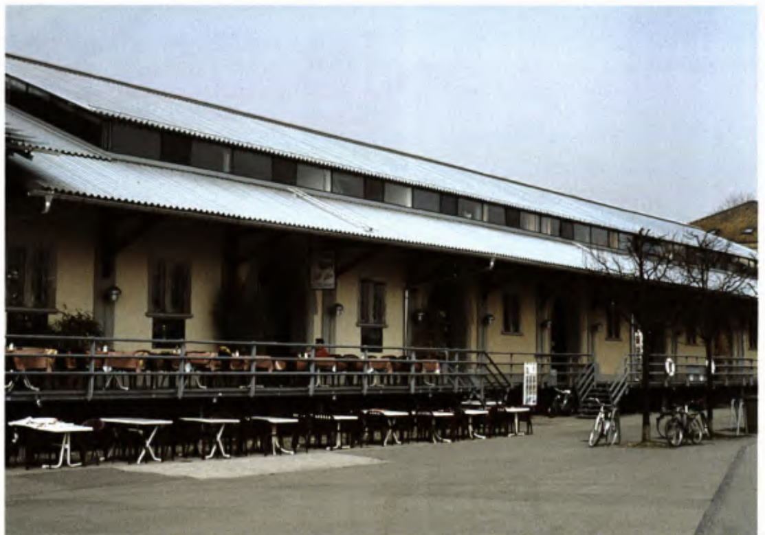
3 Das ehemalige Lagerhaus am Konstanzer Hafen ist auch nach seiner Umnutzung als Lagerhaus erkennbar. Die Reitergaube erlaubt ohne Substanzverlust eine großzügige Nutzung des Dachgeschosses.
