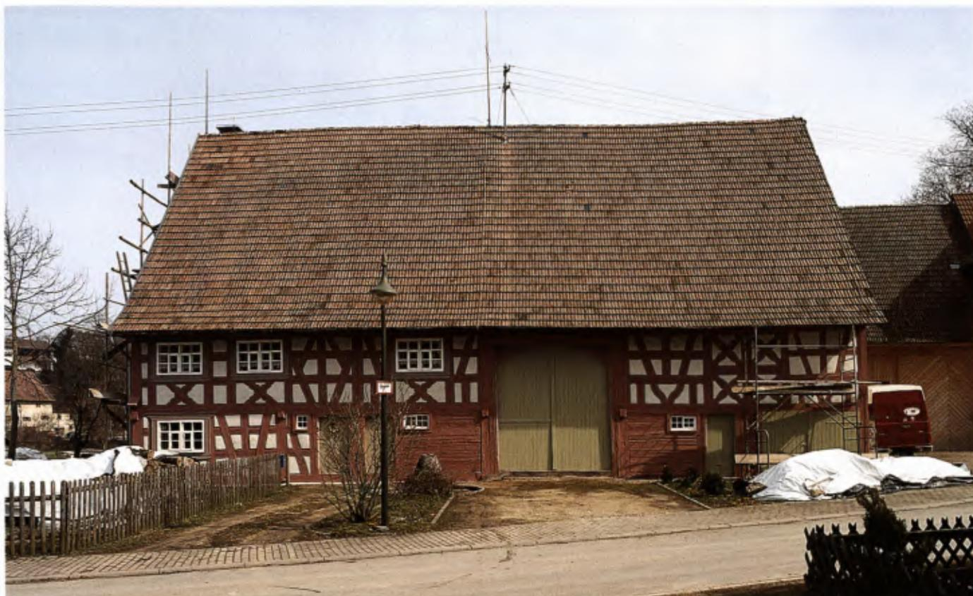
rückwärtigen Fassade und Teile des Schwellenbereiches waren keine Ergänzungen der Zimmermannskonstruktion erforderlich. Die Dachdeckung wurde auch hier unverändert beibehalten. Mit den farblichen Fassungen, welche den Befunden entsprechen, fand die Außeninstandsetzung ihren Abschluss (Abb. 3).
