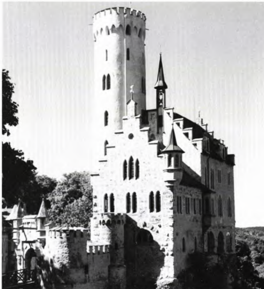
■ 1 Schloß Lichtenstein, Ansicht von Südosten.
