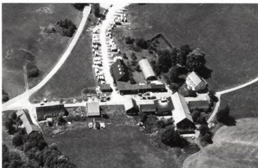
■ 1 Schmidsfelden: Luftbild des Glasmacherdorfes 1985. Am rechten Bildrand steht das Herrenhaus, im Zentrum, hin zum Sägewerk, die eigentliche Glashütte.
