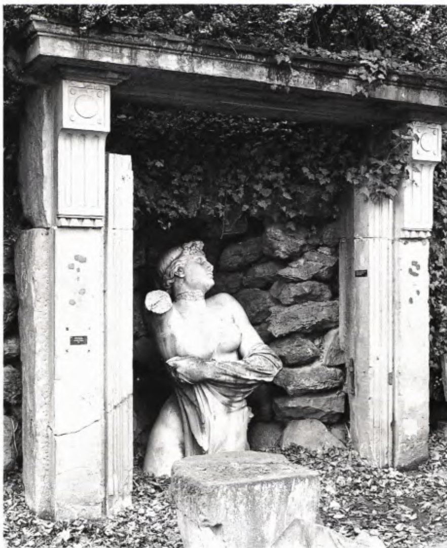
■ 5 Portaleinfassung des Gasthofs „König von England“, Sandstein, 1798, Dorotheenstr. 2 (Inv. Nr. 90). Schadensbild: Risse, statische Probleme. Außerdem zu sehen: Skulptur einer Wiesennympe (Inv. Nr. 91). Foto: Stadtarchiv Stuttgart (J. Weigele).
