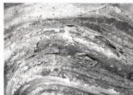
■ 9 Detail, Bärtiger Kopf als Eckkonsole, vom 1932 abgebrochenen Hofmarschallenhause, Kanzleistr. 24., Sandstein, um 1578 (Inv. Nr. 15). Schadensbild: Gelockerte Fassungsschollen. Foto: J. Weigele.
