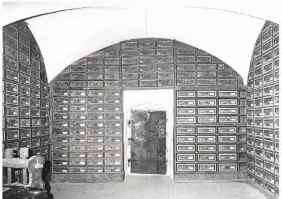
■ 1 Schloß Weikersheim, Archivraum. Das Schubladensystem wurde in der Mitte des 18. Jahrhunderts eingerichtet, nachdem der gewölbte Raum im Erdgeschoß durch vergitterte Fenster und eine massive Eisentür mit Spezialschloß vor unberechtigtem Zutritt gesichert worden war. Foto: Hauptstaatsarchiv Stuttgart.
