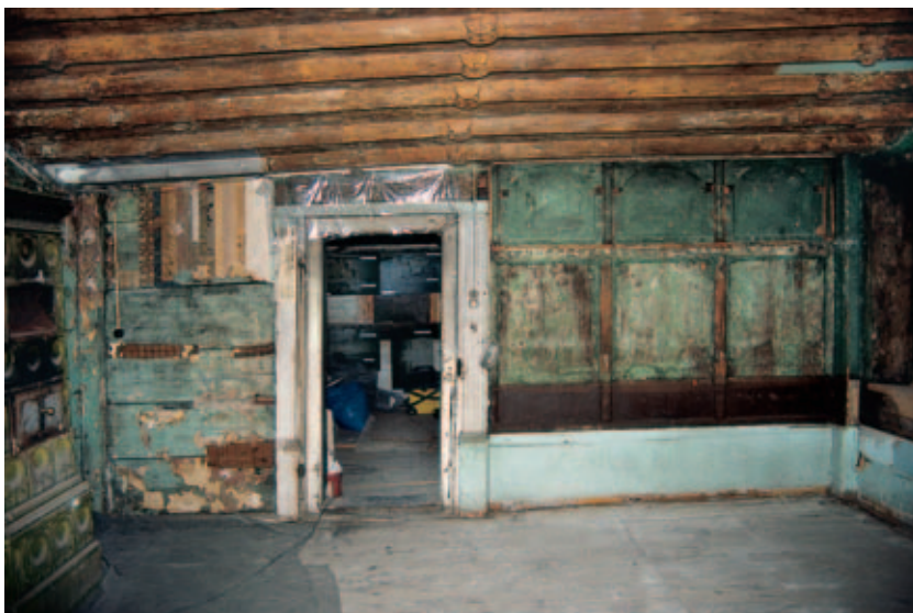
2 Eingangsbereich der Stube im Vorzustand. Rechts von der Tür der Täfer.
