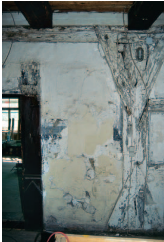
19 Flur, Außenwand der Bohlenstube rechts der Tür: Lehmwand mit Scheinfachwerk während der Freilegung und Sicherung.
