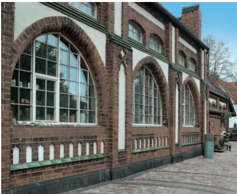
2 Kopfbau des ehemaligen Abwasserpumpwerks mit der aufwändigen Architekturgliederung.
