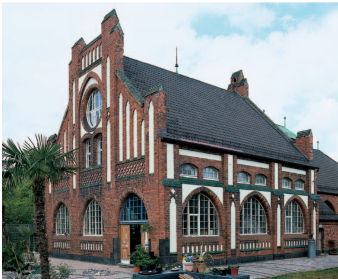
1 Mannheim-Neckarau, Kopfbau des ehemaligen Abwasserpumpwerks.
