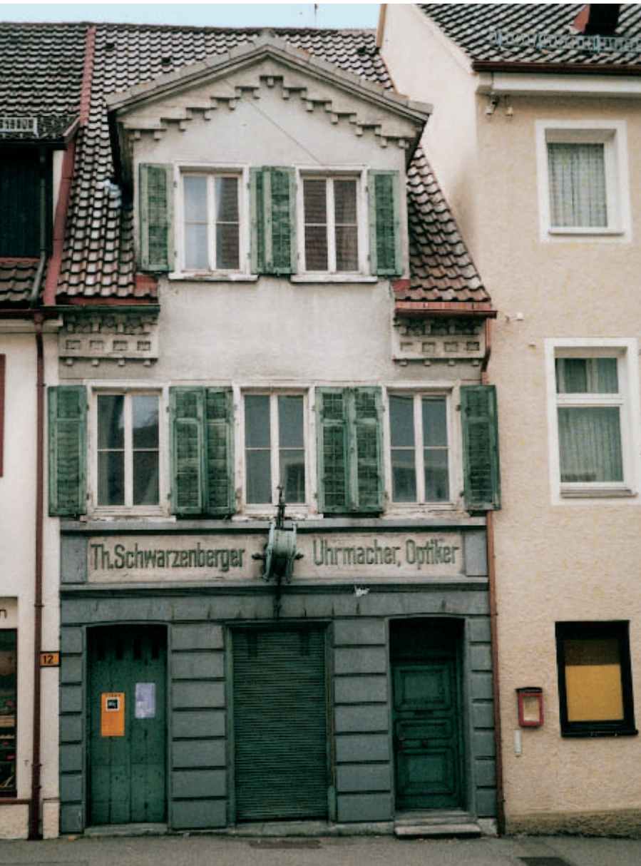
1 Isny, Gebäude Bergtorstraße 4. Derzeitige Straßenansicht.
