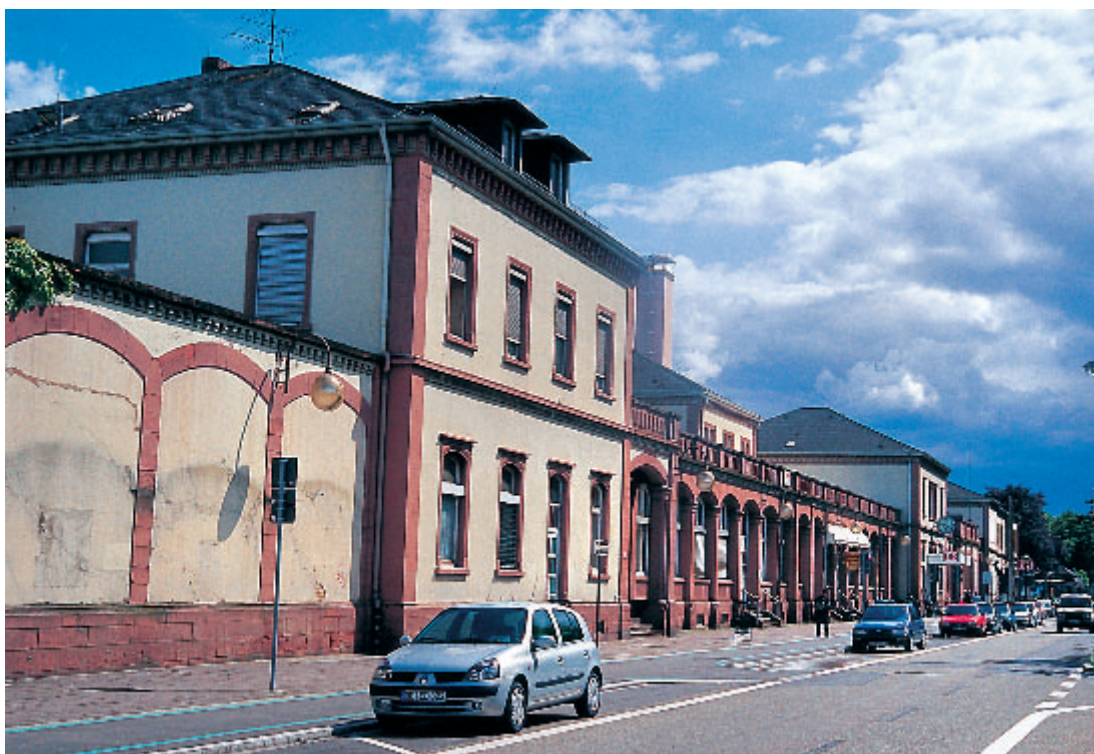
3 Bahnhof Offenburg, Empfangsgebäude mit den inzwischen geschlossenen Arkaden der ehemaligen Vorhalle.
