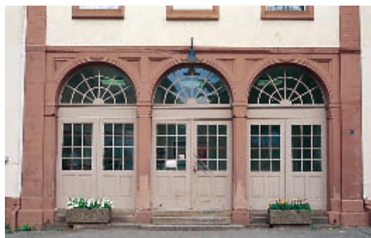
11 Bahnhof Denzlingen, Empfangsgebäude von 1864. Die Eingangssituation lässt die großzügige Konzeption der Vorhalle erkennen.
