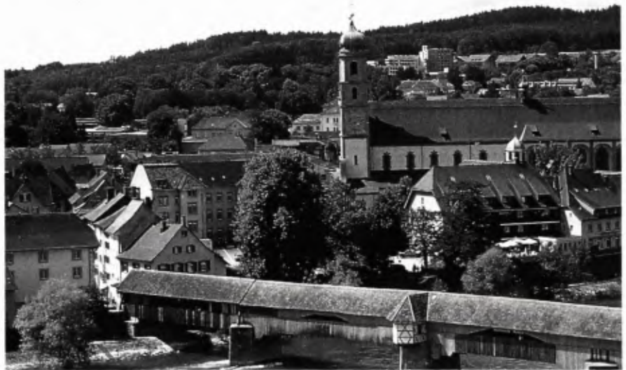
■ 1 Blick vom Schweizerischen Hochrheinufer auf Bad Säckingen mit der längsten gedeckten Holzbrücke Europas, dem Fridolinmünster und der Altstadt.
