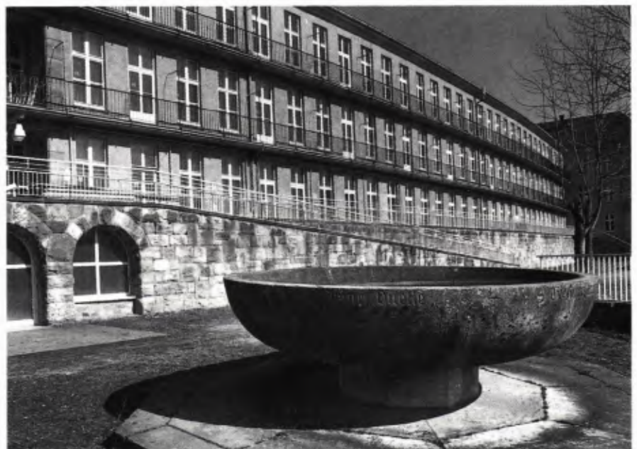
■ 3 Südfassade des Hauptgebäudes mit der Brunnenschale. Zustand bis 1997.
