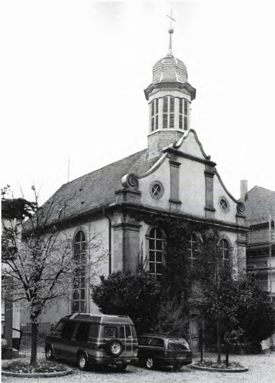
■ 1 Eichtersheim, Blick auf die Fassade der spätbarocken, früheren Kirche.
