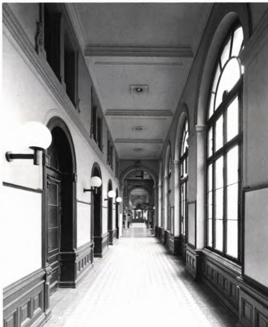
■ 4 Erschließungshalle unter der Eingangsfassade des früheren Stadtbahnhofs.
