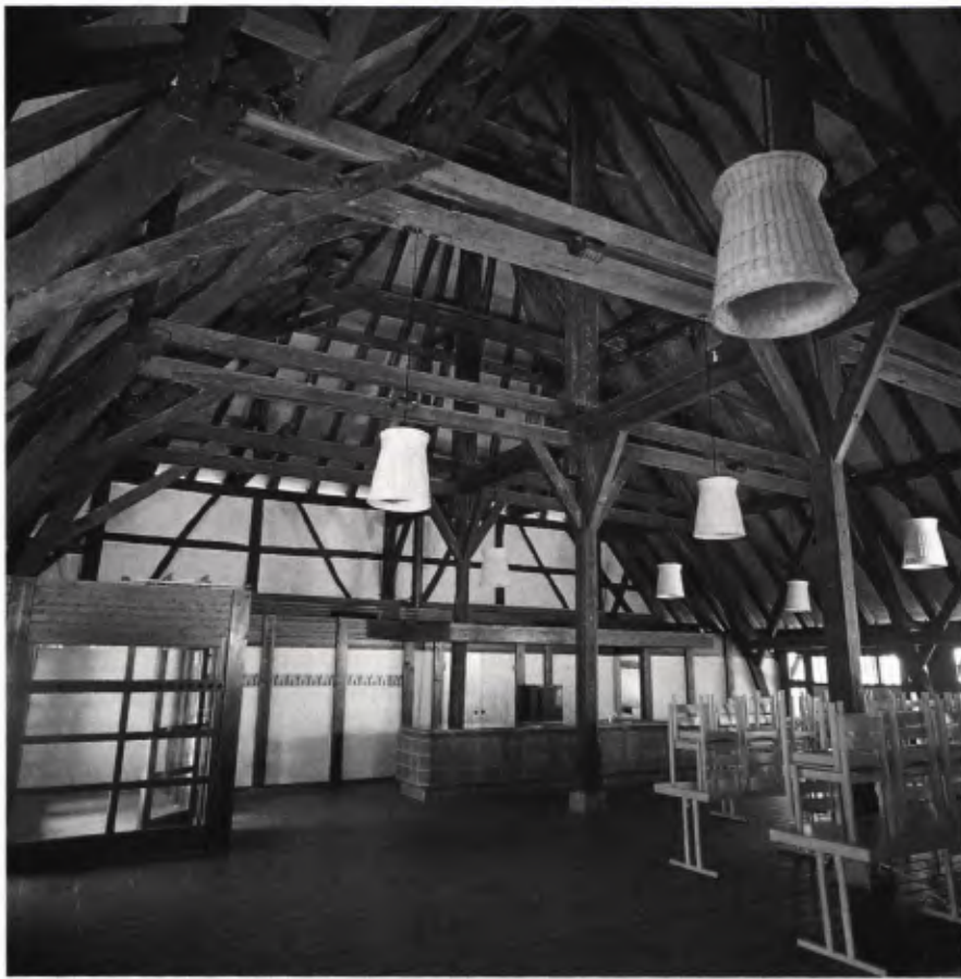
■ 4 Die Festhalle im früheren Kelterraum.
