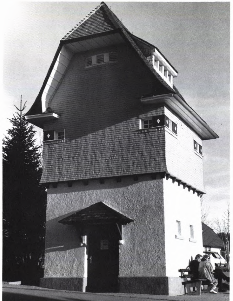
■ 6 Verschindelung und Krüppelwalm sind Architekturelemente, die im Ortskern von St. Märgen, wo sich diese Transformatorstation befindet, häufig verwandt wurden.
