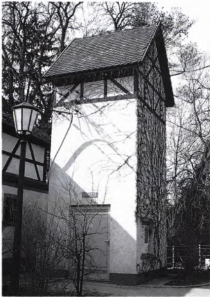
■ 5 Rücksicht auf die sie umgebende Bebauung nimmt die 1926 in Rust errichtete Transformatorstation.
