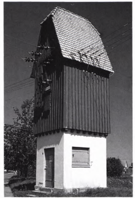
■ 8 Auch auf der Insel Reichenau wurde auf eine dem ortsüblichen Baustil entsprechende Gestaltung der Transformatorenstationen geachtet.
