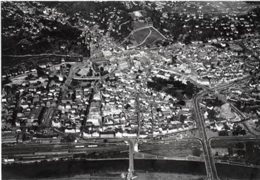
■ 2 Luftbild der historischen Innenstadt mit dem heutigen Zustand der drei Bereiche (Luftbild Elsässer).
