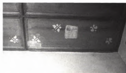
■ 5 Decke vor den Instandsetzungsarbeiten 1986. Faltermotive in Schablonenmalerei von Bruno Taut.
