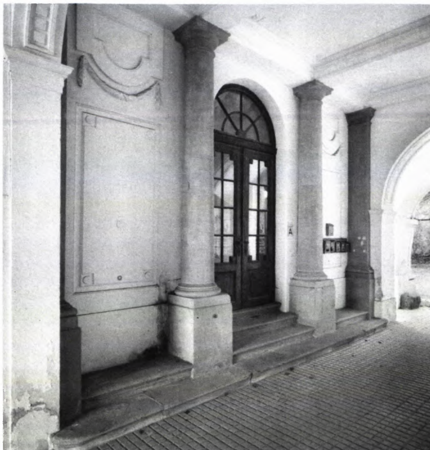
9 HOFDURCHFART und Eingang zum Treppenhaus; Aufnahme 1980.
