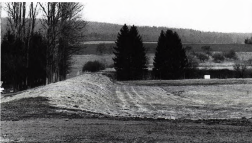
15 DAMM des Abt-Gerhard-Sees , 1987, von Süden.
