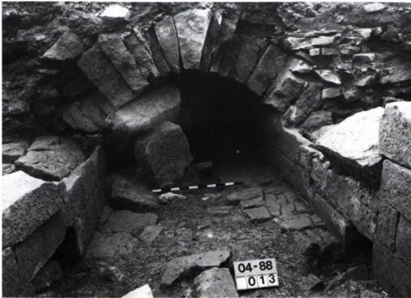
11 BEIM BAU der Fernwärmeleitung wurde 1988 der Kanal im Klosterhof zerstört.
