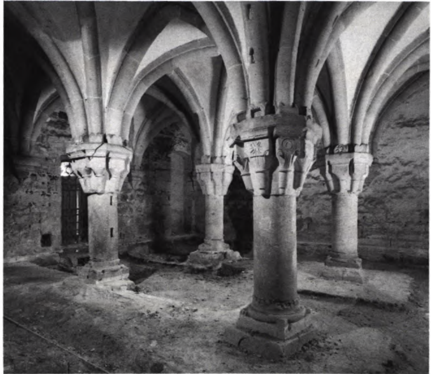
2 PARLATORIUM, Aufnahme bei Grabungsbeginn im Februar 1987 von Südosten.
