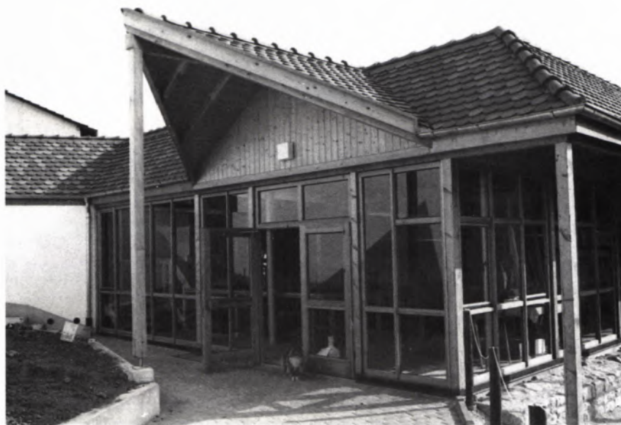
3 EINGANG in das Schutzhaus.
