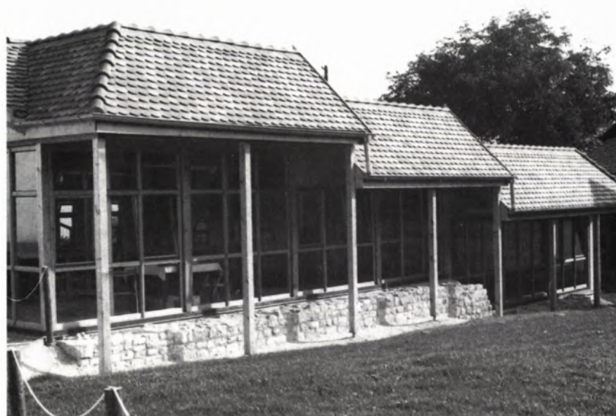
4 DIE GROSSEN GLASFLÄCHEN des Schutzbaues erlauben einen Durchblick auf die konservierte Anlage.
