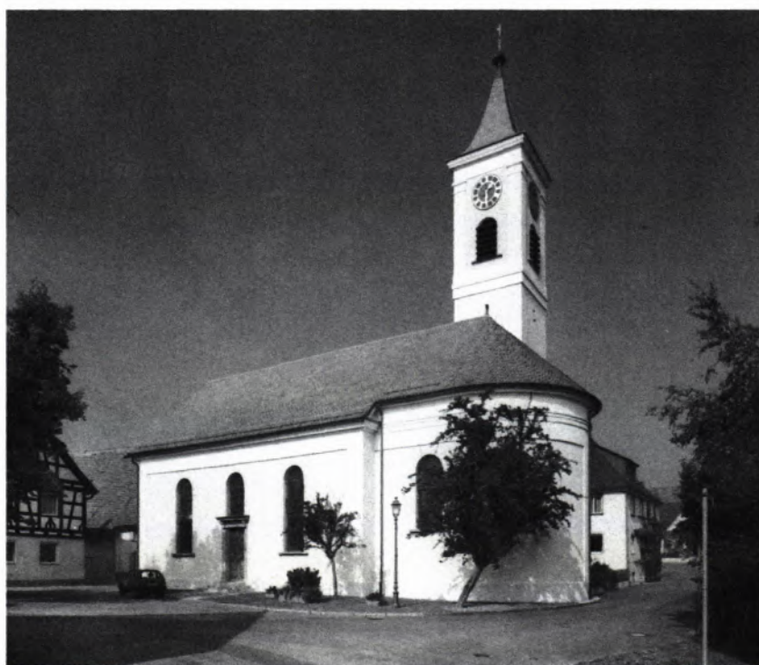
1 ALTE PFARRKIRCHE ST. VITUS in Fischbach nach der Renovierung, die 1978 begonnen und 1986 abgeschlossen wurde.
