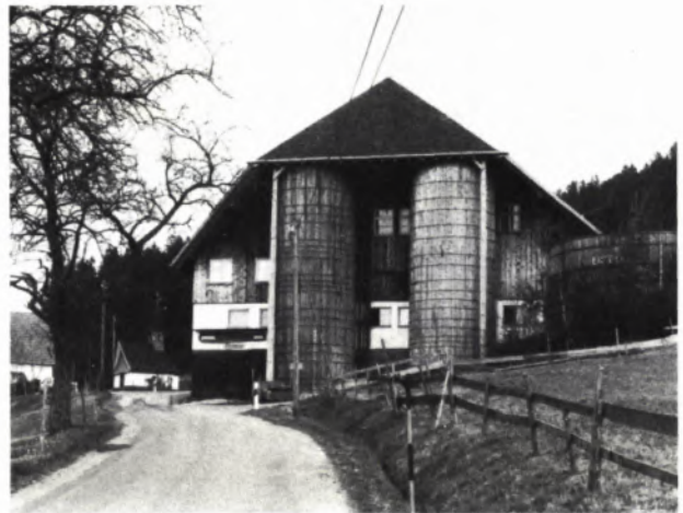
2 DERSELBE HOF mit modernem Stallteil und mächtigen Futtersilos (1983).
