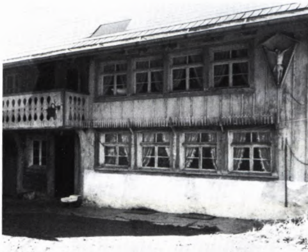
5 WOHNTTEIL eines „Heidenhauses“ mit weitgehend intakten Fensterbänken und verputzten Bohlenständerwänden (1978).
