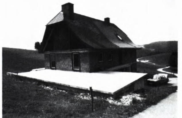
10 DIESES BERGHAUS 1983: massiv gemauerte Wände, Betondecken, Garagenanbau, Flächenfenster.
