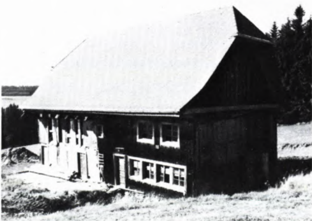
9 BERGHAUS mit weitgehend erhaltener Konstruktion. Kaum verändertes Fensterband im Bereich der Stube (1978).
