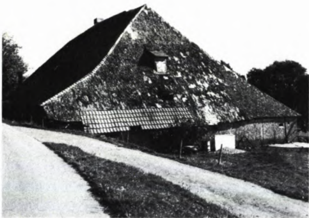
7 „HEIDENHAUS“ mit charakteristisch tiefgezogenem Walm und überwiegend erhaltener Schindeldeckung (1978).
